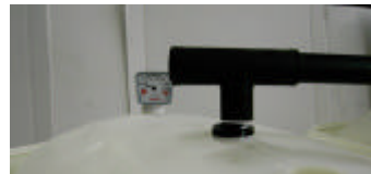
Bild 6b: Entlüftungsleitung einschieben
